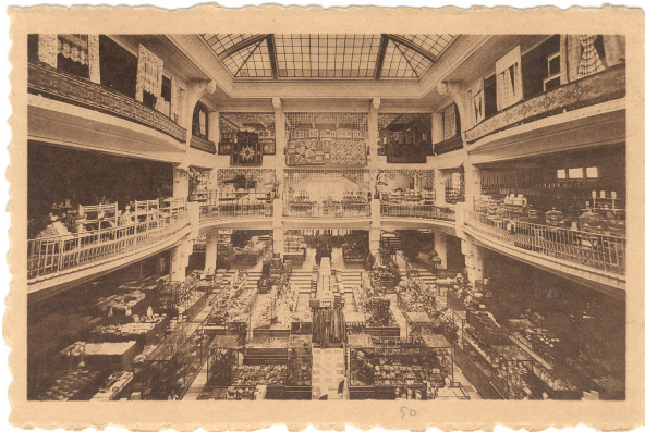
Elegant warenhuis met groot glazen dak, overkoepelde atrium en smalle galerijen als omloop rond vide, 1921, verzameling André Verbeke
