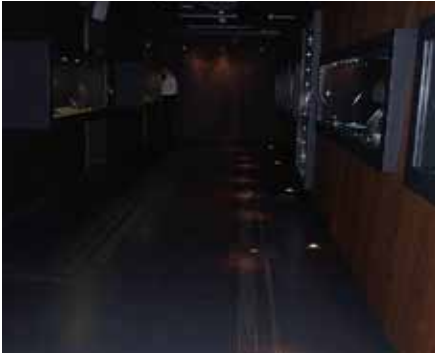
Goed voelbare vloerbewegwijzing met onvoldoende zichtbaar contrast.
