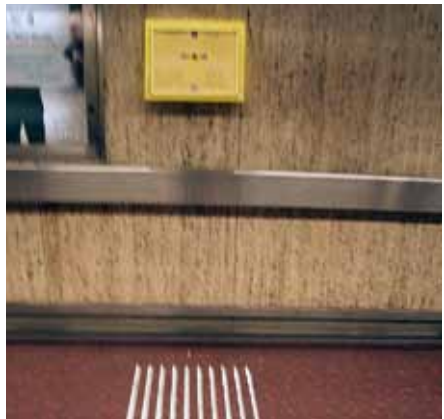
Bewegwijzing via muurpaneel in Brusselse metro met geleidelijn.
