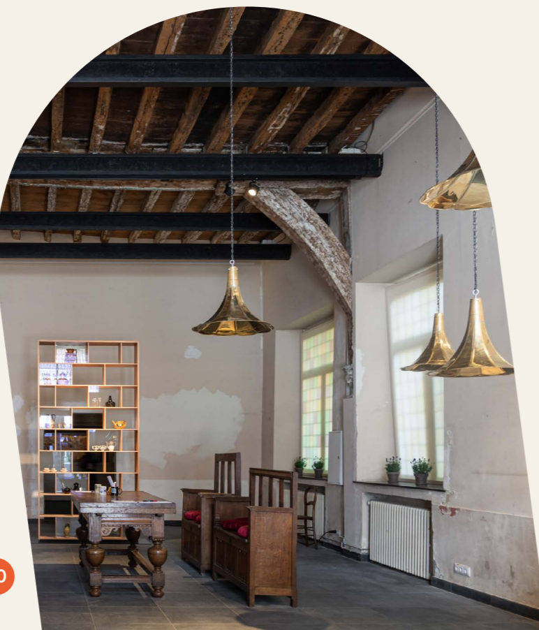
Nieuwe balken met technische inplugpunten. Foto Jason Slabbynck
